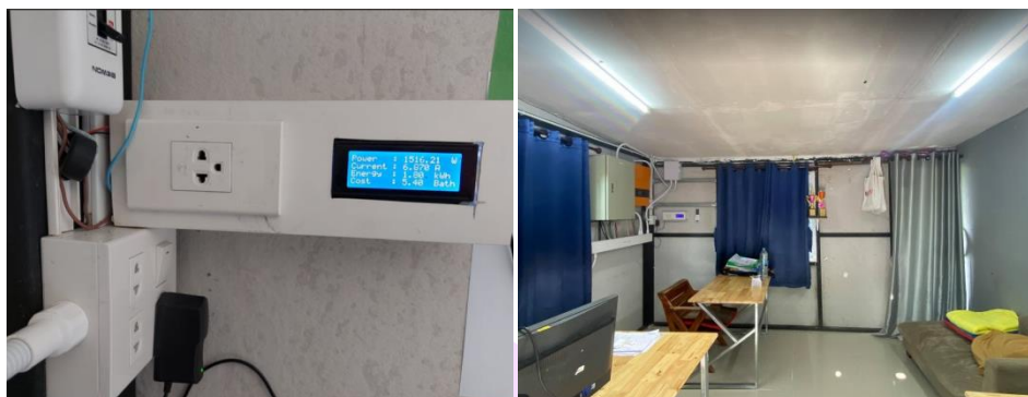
ภาพ 59 การติดตั้งสมาร์ทมิเตอร์ที่ห้องออฟฟิศสวนพลังงานมหาวิทยาลัยราชภัฏ กำแพงเพชร
