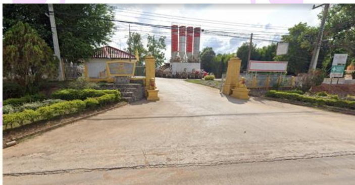
ภาพ 40 แสดงอุตสาหกรรมเกี่ยวกับก่อสร้างและโรงไม้หิน
