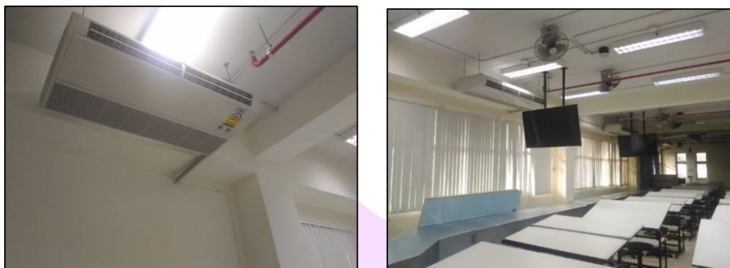
ภาพ 33 เครื่องปรับอากาศที่ติดตั้งในพื้นที่ทดสอบ
