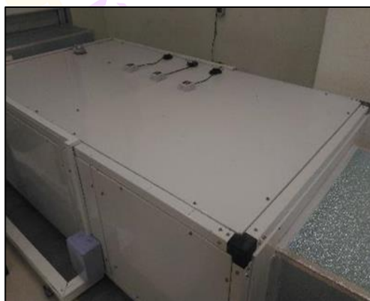
ภาพ 48 ชุดเครื่องส่งลมเย็นต้นแบบ (Air Handling Unit, AHU) พร้อมติดตั้ง อุปกรณ์ปรับรอบ (Variable Speed Drive, VSD)
