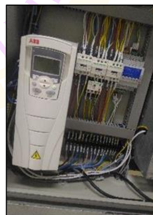
ภาพ 48 ชุดเครื่องส่งลมเย็นต้นแบบ (Air Handling Unit, AHU) พร้อมติดตั้ง อุปกรณ์ปรับรอบ (Variable Speed Drive, VSD)
