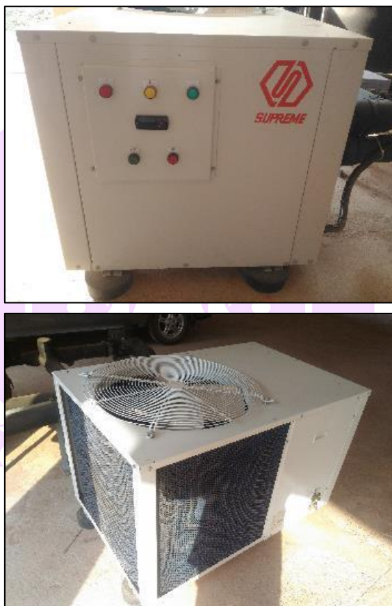
ภาพ 46 ชุด Air-cooled chiller, CH1
