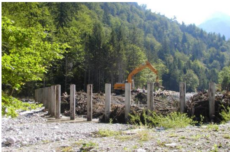
ภาพ 10 การประยุกต์ใช้ฝายชะลอน้ำแบบเปิดเสาเข็มในการตัดเศษไม้
