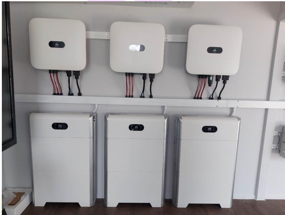
ภาพ 38 แบตเตอรี่ลิเทียมโพลีโพรพิลีน (LifePO4) Huawei LUNA 2000 Battery Smart Kit 5 kW ติดตั้งสวนพลังงาน มหาวิทยาลัยราชภัฏกำแพงเพชร
