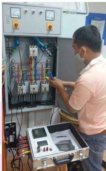
ภาพ 34 ติดตั้งเพาเวอร์มิเตอร์ในการเก็บข้อมูลการใช้ไฟฟ้าของอาคาร
