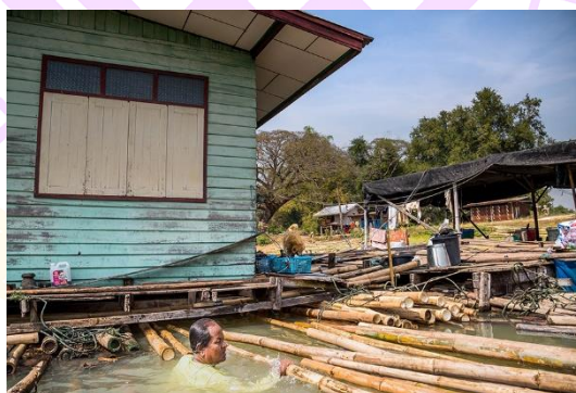
ภาพ 31 การซ่อมแซมเรือนแพ
