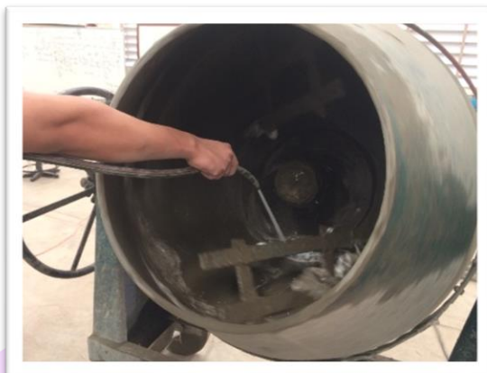
ภาพ 30 ฉีดน้ำยาโฟมลงในเครื่องผสมคอนกรีต
