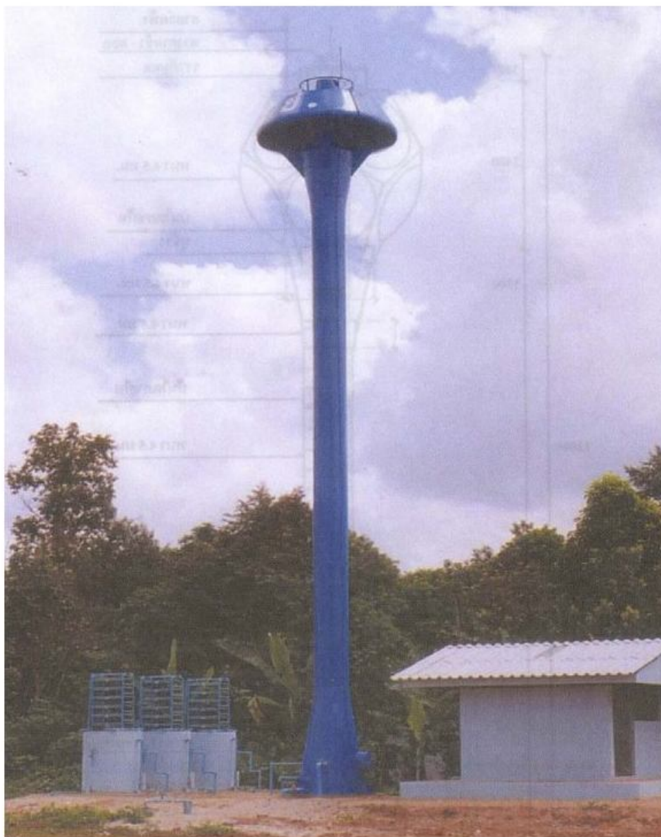
ภาพ 8 แสดงหอดังเหล็กแบบทรงกลมขอบเหลี่ยม ขนาด 12 ลูกบาศก์เมตร
