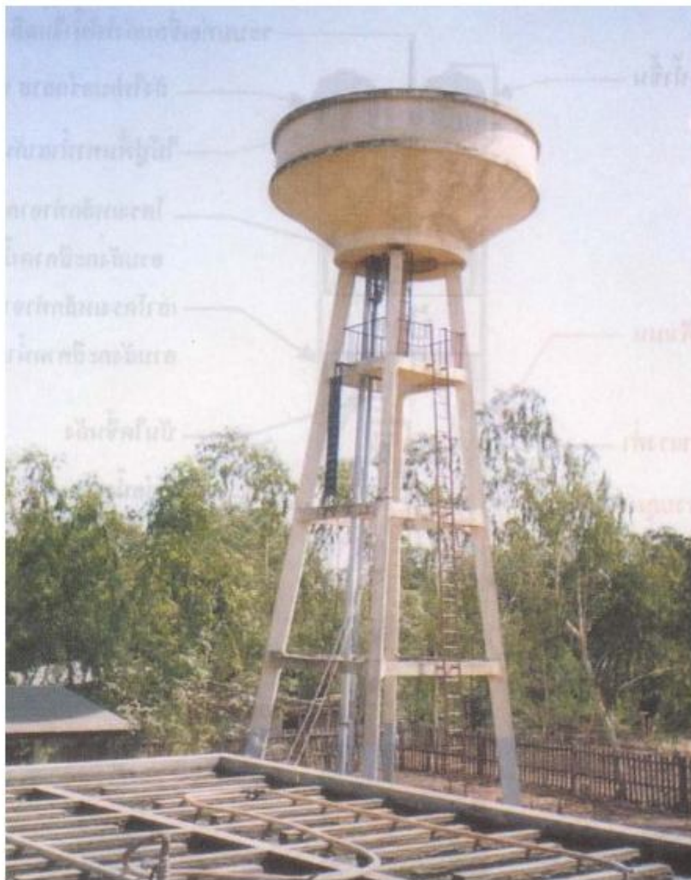
ภาพ 11 แสดงถังคอนกรีตเสริมเหล็ก
