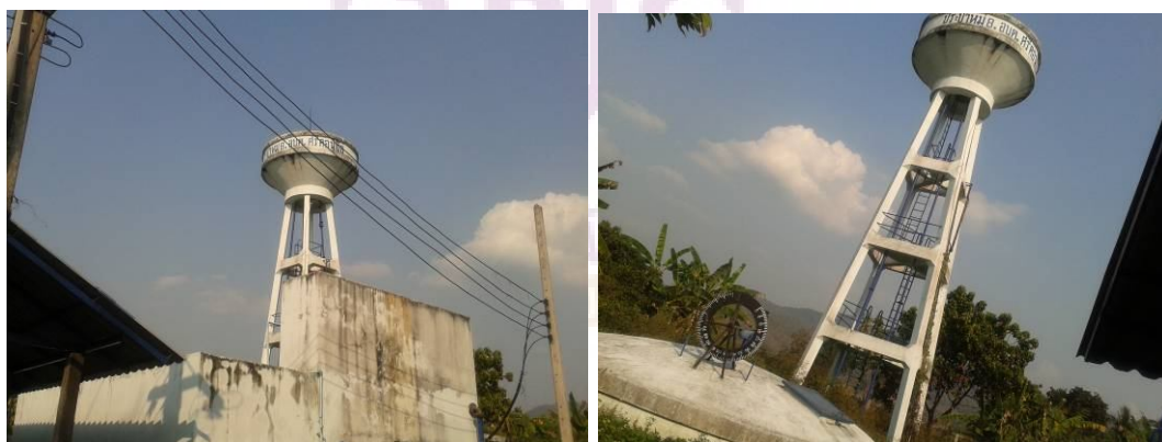
ภาพ 24 แสดงระบบประปาชุมชนบ้านหวาย
