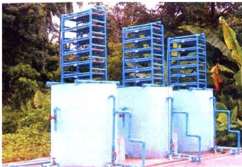
ภาพ 7 แสดงถังกรองตะกอนและสนิมเหล็กระบบกรองช้า
