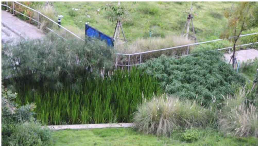
ภาพ 9 ระบบแบบการไหลใต้ผิวชั้นกรองในแนวราบ (HF)
