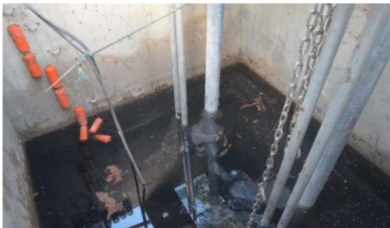
ภาพ 6 ภายในบ่อพักน้ำเสียมีเครื่องสูบน้ำเสีย 2 เครื่อง
