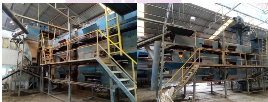
ภาพ 11 การลดความชื้นปุ๋ยอินทรีย์ด้วยความร้อน จำนวน 2 ครั้ง
