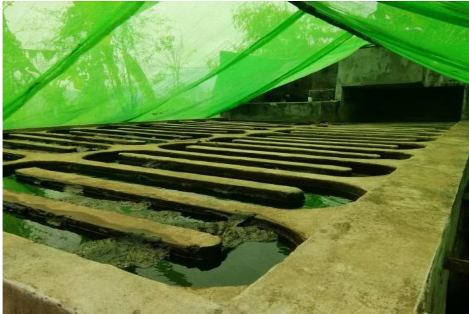
ภาพ 22 แสดงระบบถังกรวนช้า ระบบกรองน้ำ ของระบบประปาหมู่บ้าน บ้านโป่งน้ำตก
