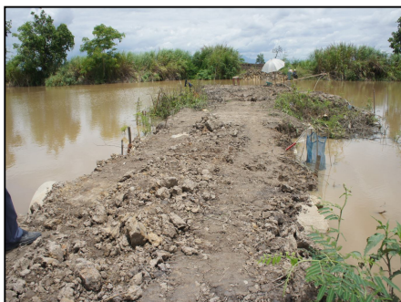
ภาพ 5 แสดงทำนบดินชั่วคราวที่ราษฎรดำเนินการเองเพื่อกักน้ำไว้ในหนองหลวง ขณะสำรวจพื้นที่ทำนบดินถุกขังเพื่อระบายน้ำจากหนองหลวง
