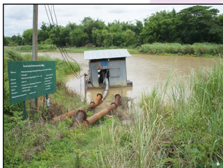
ภาพ 6 แสดงราษฎรตั้งเครื่องสูบน้ำเพื่อนำน้ำจากน้ำแม่ลัวไปใช้เพื่อการเกษตร และลักษณะ คูน้ำที่เกษตรกรขุดเพื่อส่งน้ำเข้า
