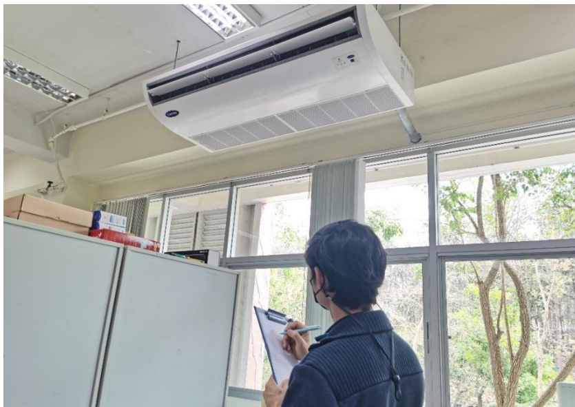
ภาพ 55 การสำรวจเครื่องปรับอากาศภายในคณะพลังงานและสิ่งแวดล้อม
