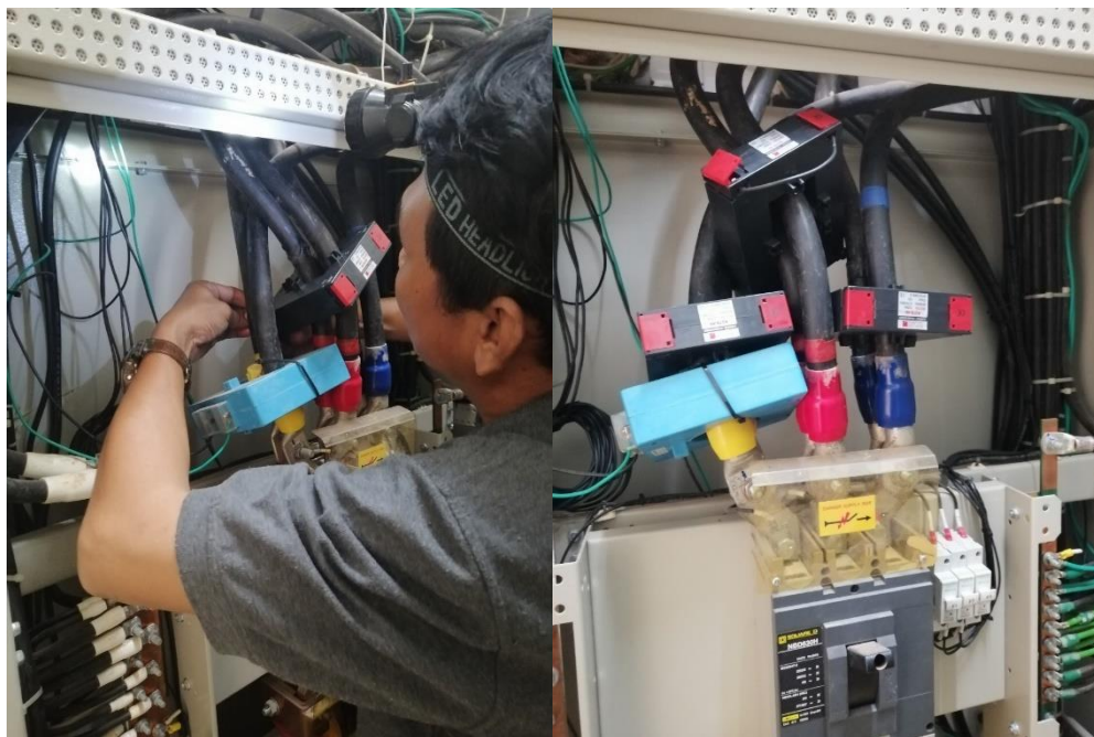
ภาพ 59 ติดตั้งตัวแปลงกระแสไฟฟ้า (Current Transformer) จำนวน 9 ตัว ตรงบริเวณ ห้องไฟฟ้าชั้นสองเพื่อวัดกระแสไฟฟ้าชั้น 1 ชั้น 4 และทั้งอาคาร คณะพลังงาน และสิ่งแวดล้อม
