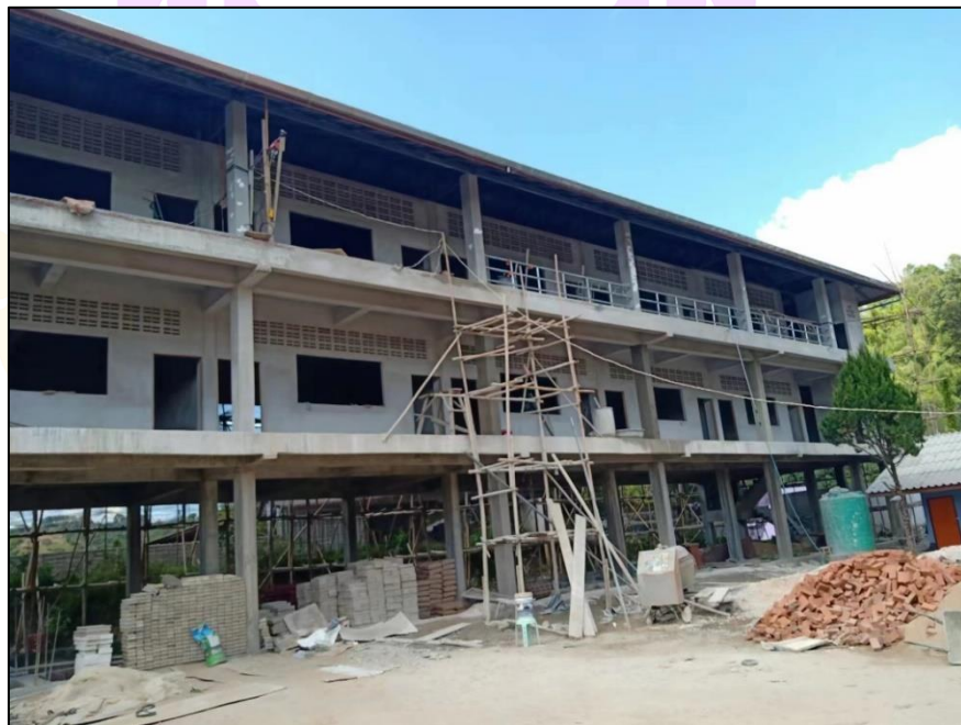
ภาพ 22 โรงเรียนจิ่งฉวินวิทยาคมในพื้นที่บন্দอยสูงในจังหวัดเชียงรายที่กำลังก่อสร้างอาคารเรียนใหม่ซึ่งได้รับความช่วยเหลือจากกงสุลใหญ่แห่งสาธารณรัฐประชาชนจีนประจำเชียงใหม่
